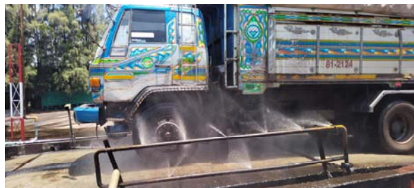
รูปที่ 2-4 การล้างล้อรถบรรทุก
